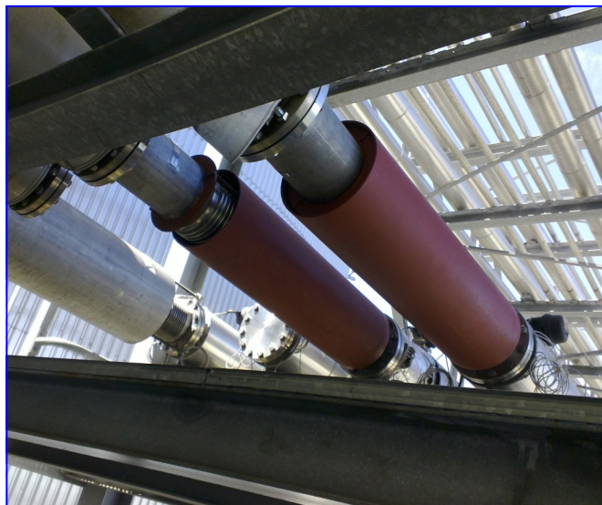
Axiaalcompensator (DN200) voor grote bewegingsopname, opgebouwd uit meerdere balgelementen, voorzien van bewegingsbegrenzing en buitenbescherming ter bescherming en geleiding.
