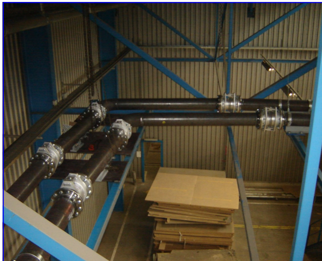
Systeem van 3 scharniercompensatoren om grote uitzettingen van het leidingwerk op te vangen, zonder drukreactiekrachten te genereren. Dergelijke oplossing is ideaal voor opgehangen leidingen, waar de mogelijkheid om stevige verankeringen te voorzien vaak niet bestaat.
